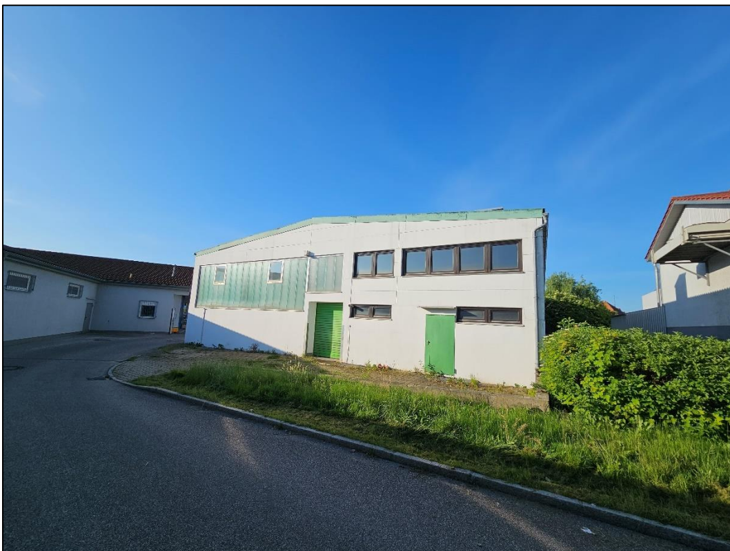
Abbildung 28: Nordseite des Baumarktes. Blick Richtung SS0.
