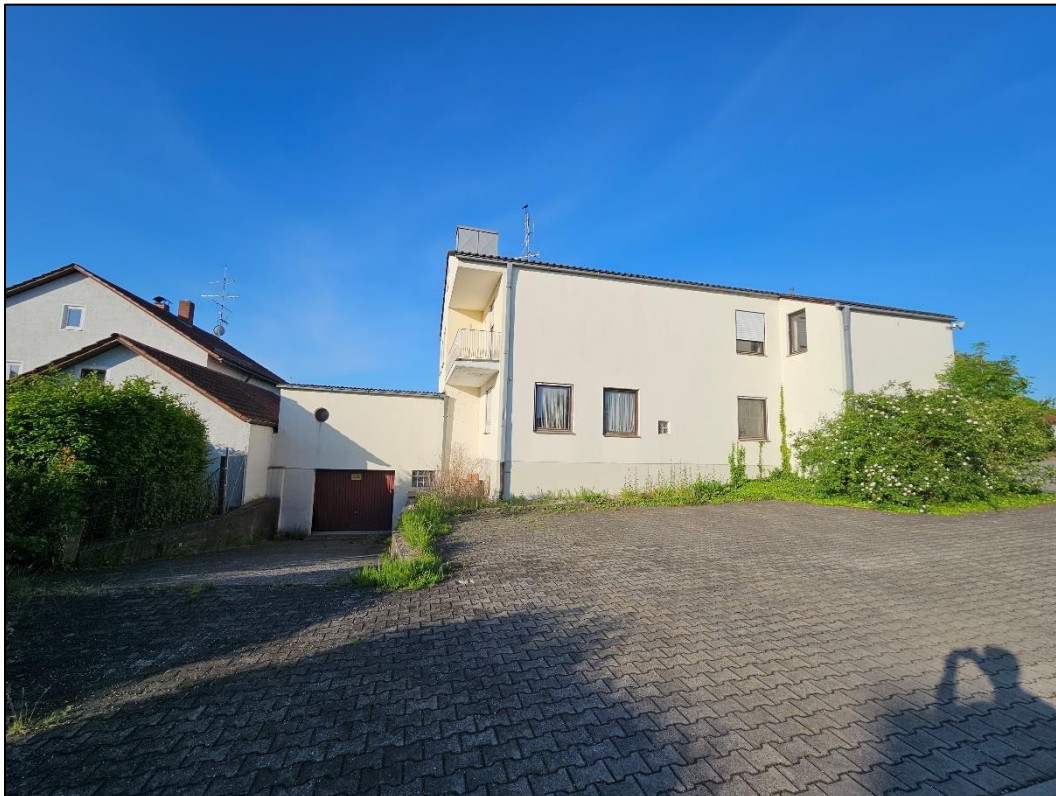
Abbildung 12: Nordseite des Wohnhauses mit Garage. Blick Richtung Süden.
