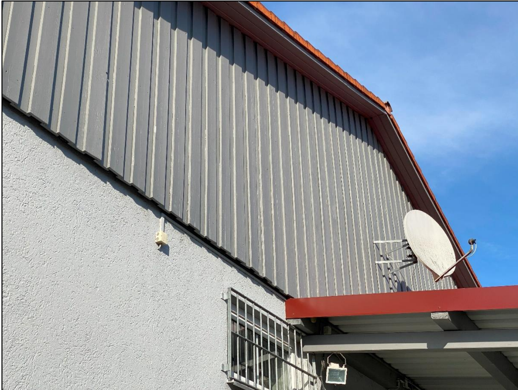
Abbildung 35: Holzfassade an der Ostseite des EDEKA-Markts.
