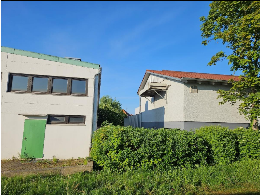
Abbildung 27: Penny-Markt rechts im Bild, Baumarkt links im Bild. Blick Richtung Süden.
