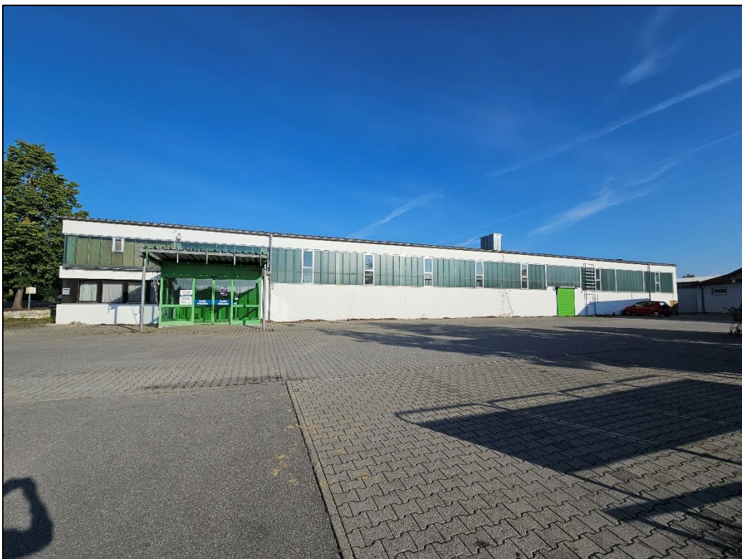
Abbildung 16: Leerstehender Baumarkt im Zentrum des UG. Blick Richtung Osten.
