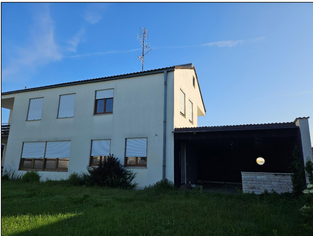
Abbildung 8: Südseite des Wohnhauses mit Garage.
