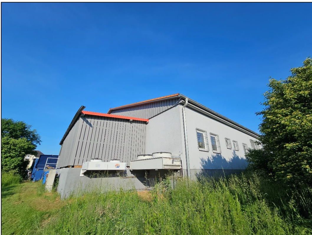
Abbildung 36: Nordöstliche Ecke des EDEKA-Markts. Blick Richtung Südwesten.
