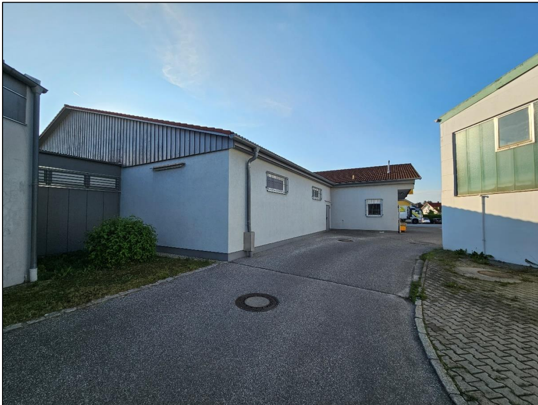
Abbildung 30: Zufahrt zum EDEKA-Parkplatz von Nordwesten. EDEKA-Gebäude links und Baumarkt rechts im Bild. Blick Richtung Osten.
