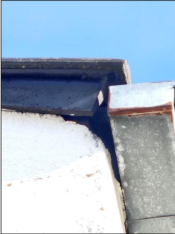
Abbildung 11: Nische für Gebäudebrüter an südwestlicher Ecke des Wohnhauses. Übergang von Ortgang zur Traufe.
