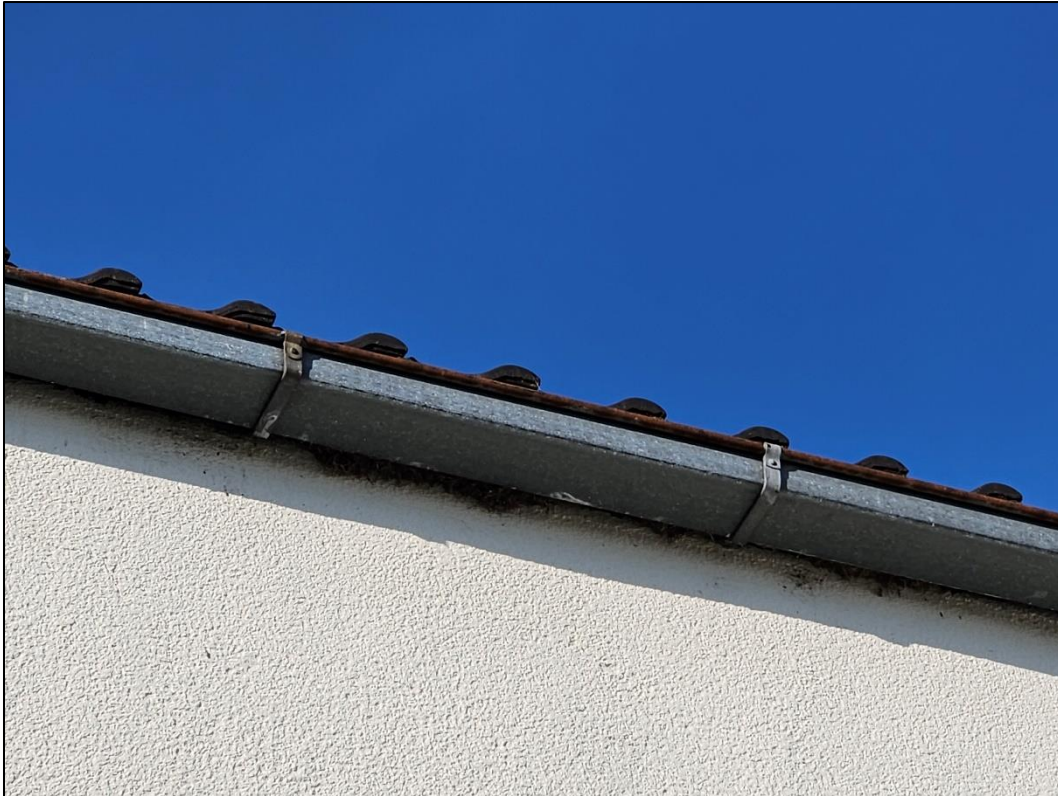
Abbildung 13: Vier Haussperling-Brutplätze hinter Dachrinne an der Nordseite des Wohnhauses.
