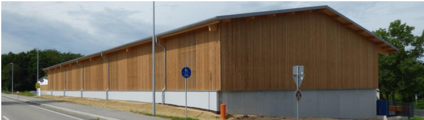
Der Neubau der Bauhofhalle gehörte zu den größten Investitionen am Jahr 2024.
